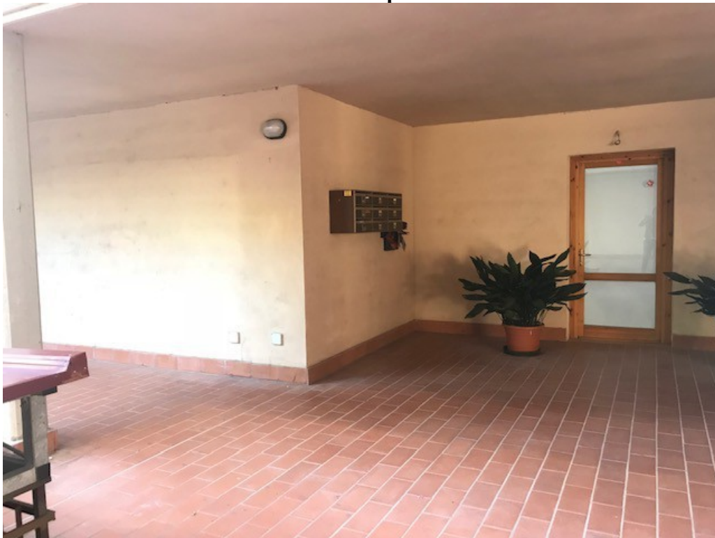
Foto 8 – vista della corte sul retro
