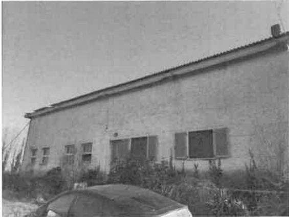
13 – Esterno del fabbricato ad uso magazzino
