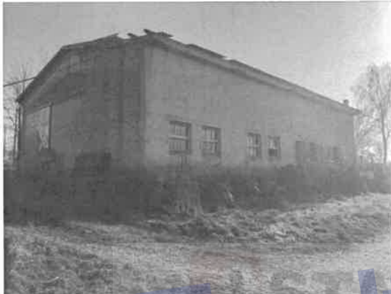
14 – Esterno del fabbricato ad uso magazzino
