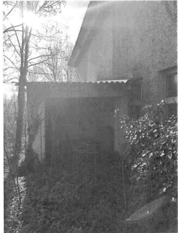
15 – Esterno del fabbricato ad uso magazzino
