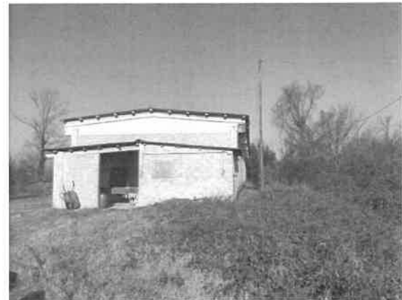
32 – Esterno del fabbricato ad uso avannotteria
