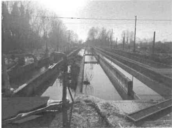
43 - vasche esterne ad uso avannotteria
