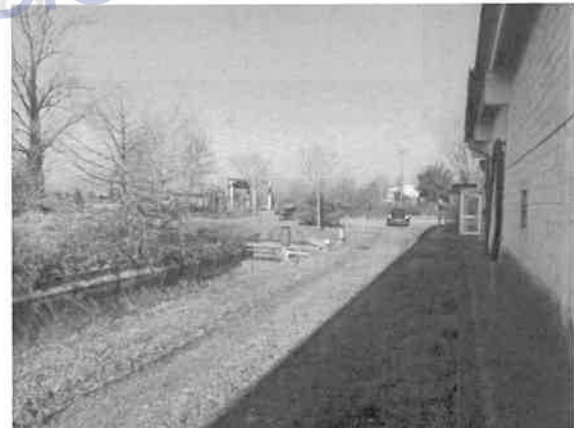
30 – Esterno del fabbricato ad uso avannotteria
